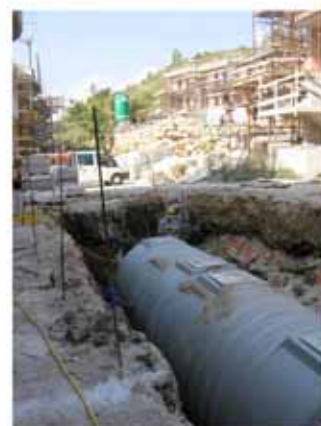
serbatoi per il recupero acque meteoriche
