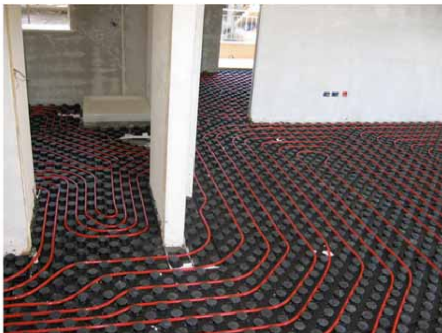
impianto di riscaldamento a pavimento a bassa temp.
