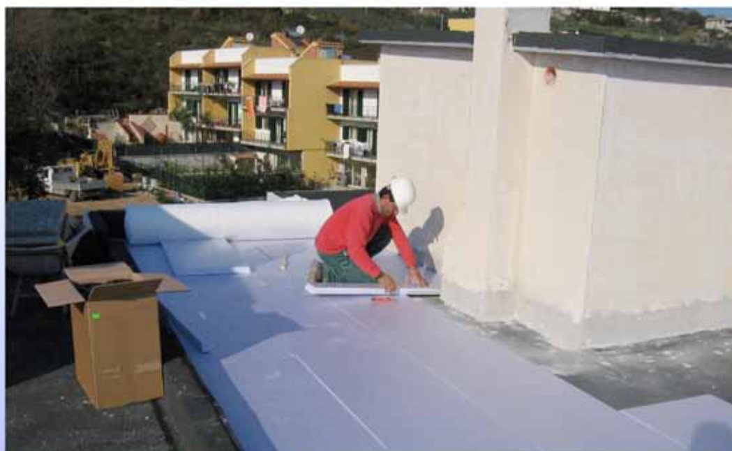
installazione del materiale isolante
