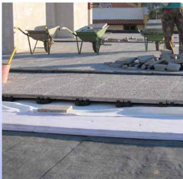
isolamento copertura - tetto ventilato
